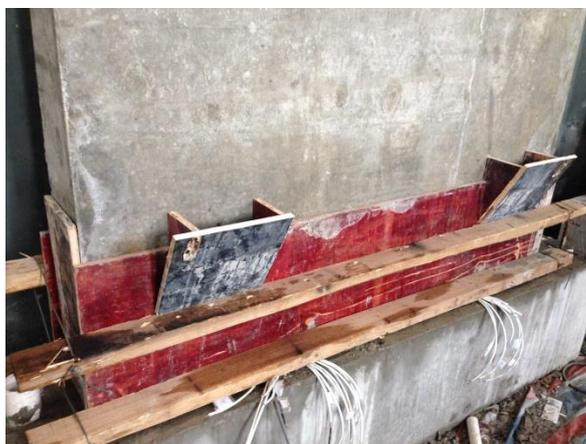
(c) 混凝土后浇区模板及施工洞预留
