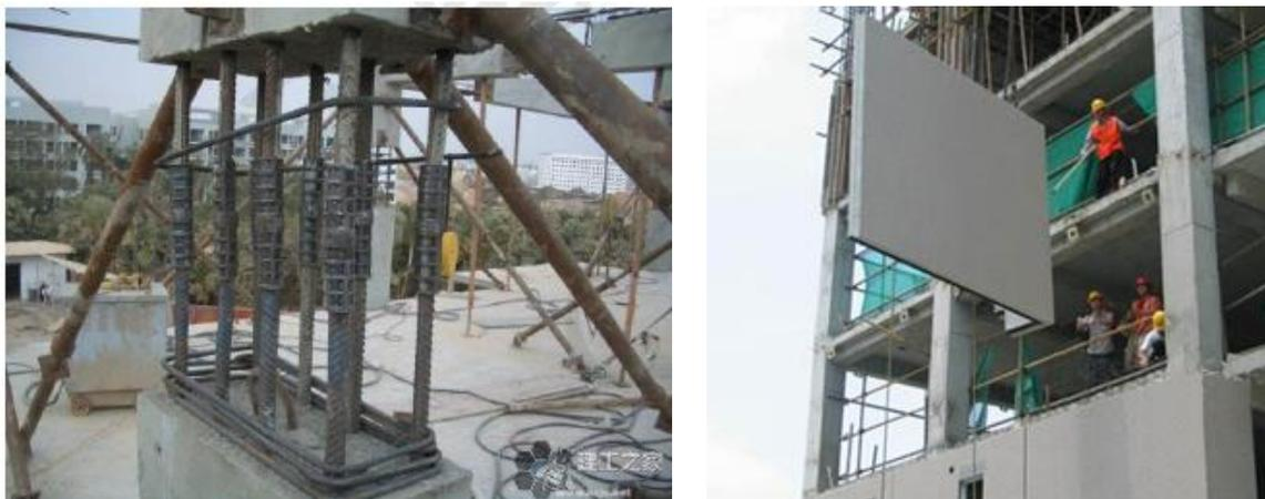
(a) 冷挤压套筒连接梁中点锚固连接
