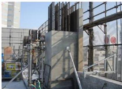
图1-1日本新泻预制框架结构
